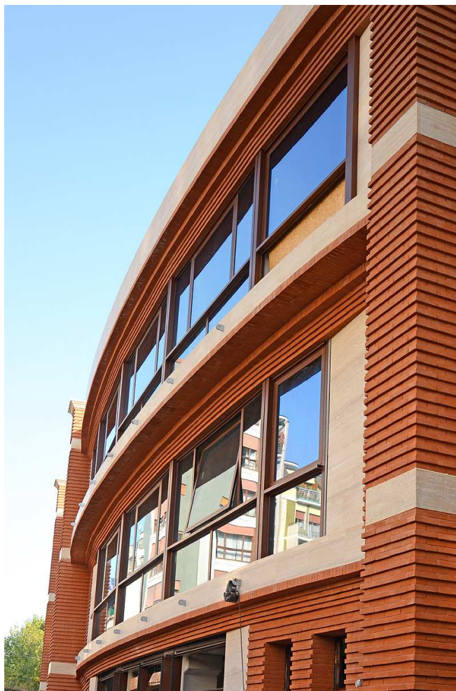
Palazzo di Giustizia Milano | Rivestimenti con mattone a pasta molle San Marco
